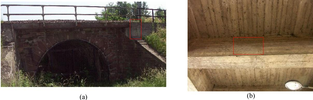
Fig. 42 : (a) pont ferroviaire testé avec la zone fissurée encadrée. (b) pont circulé et la zone non fissurée et recouverte de poussière en rouge.
