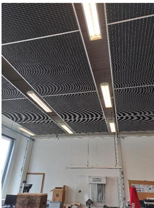
Grâce à notre maquette, et à l'aide d'un Luxmètre nous avons déterminé la puissance minimale qu'il nous faudrait pour éclairer. Nous aurons besoin au minimum de 3200 Lux.
